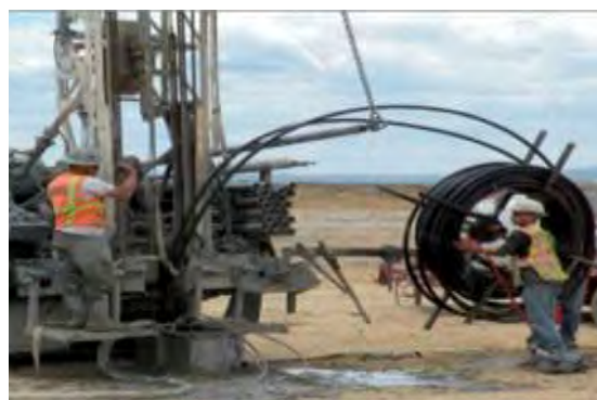
Geosonda v vrtini ( \approx 3,8 - 7,5 \text{ kW} / 100 \text{ m} ). www.renewableenergyfocus.com
