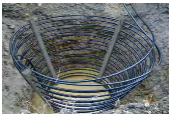
Energetska košara ( \approx 1 - 3 \text{ kW} na košaro globine do 5 \text{ m} ). info.uponor.lv
